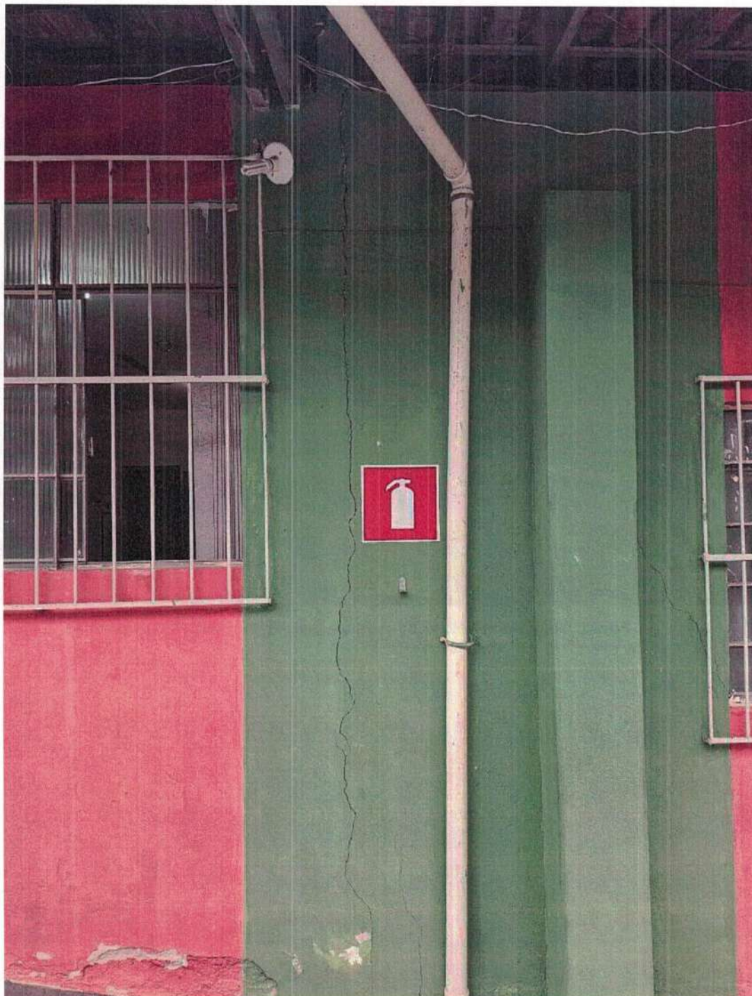
Foto 12: Paredes da área externa com trincas a serem reparadas
